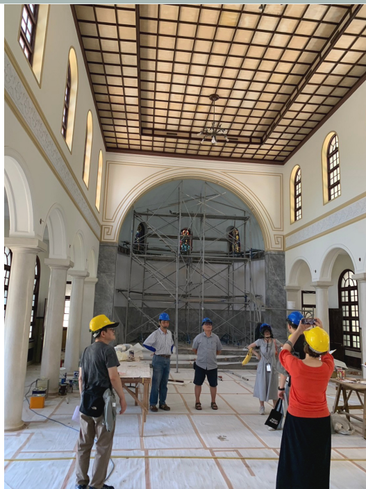
▷校園導覽模擬（南神禮拜堂內古蹟修復工程）
